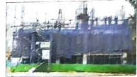
निर्माणाधीन चंद्रावल प्लांट
