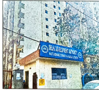
गोविंदपुर पुलिस स्टेशन के पास हुआ है टावरों का निर्माण
